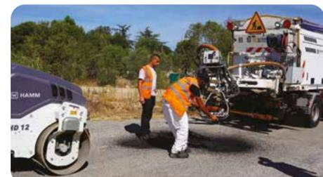
Ces réfections ont été réalisées par la société Via-Patch grâce à la méthode « blow-patcher », mini-centrale d'enrobés qui projette une émulsion de bitume. Cette technique permet de réparer durablement et en un seul passage les dégâts de chaussée localisés. L'appareil fabrique différents enrobés de qualité en fonction des types de dégradations et dose avec précision chaque besoin.
