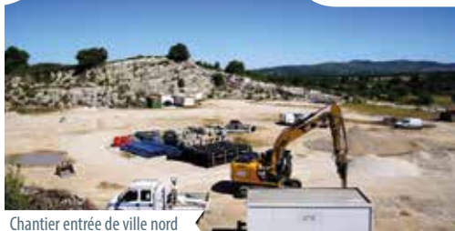
Chantier entrée de ville nord
