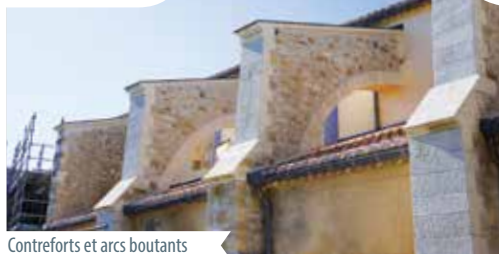
Contreforts et arcs boutants
