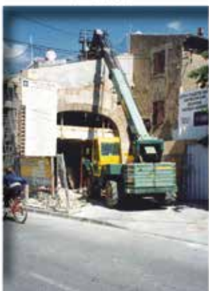
Année 1999 : un chantier d'envergure, un patrimoine valorisé
