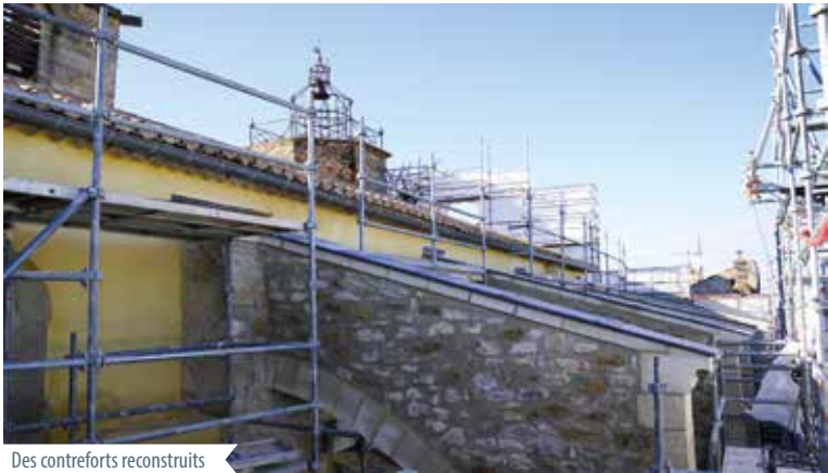
Des contreforts reconstruits
