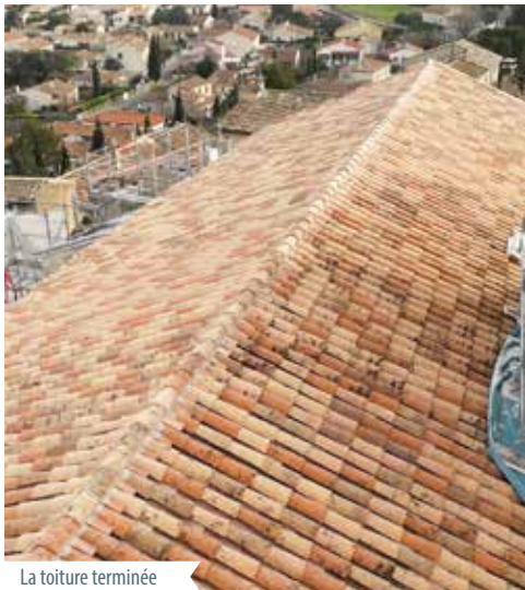
La toiture terminée
