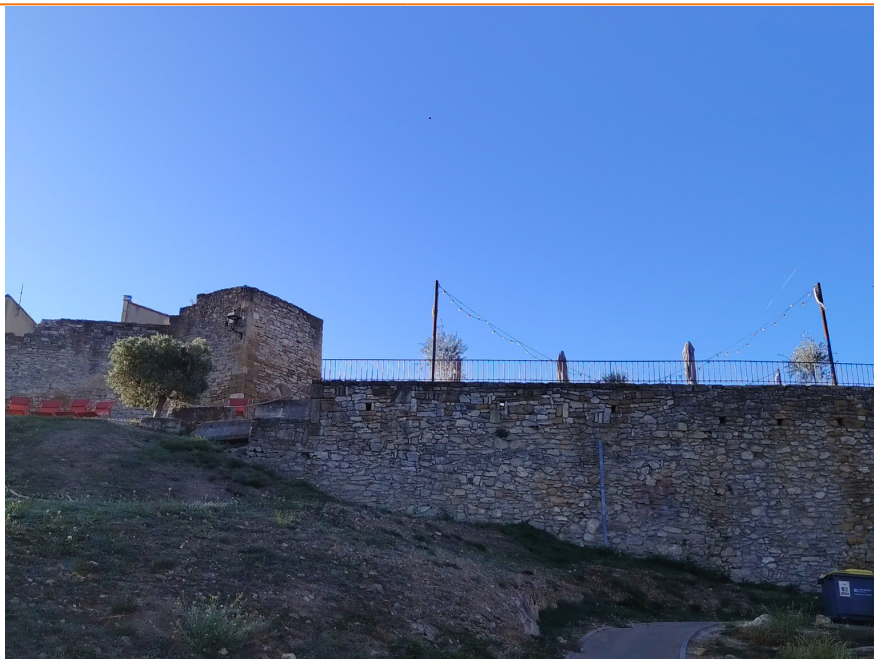
Vue extérieure du site et mur périphérique.
