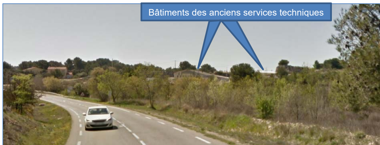
Figure 66 : Vue du site depuis la RD15
