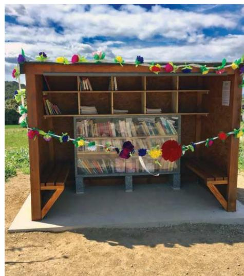
Les services techniques ont assuré le terrassement et la dalle et installé la structure en bois réalisée par les Ateliers de la Crau. Nos bénévoles ont réalisé les aménagements intérieurs. L'armoire métallique repose sur des plots en marbre offerts par Eric Mathurin.
