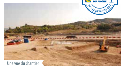
Une vue du chantier
